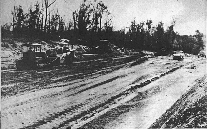
▲ Jalan Raja di-kawasan luar bandar sedang di-bena oleh pekerja2 Jabatan Kerja Raya.
